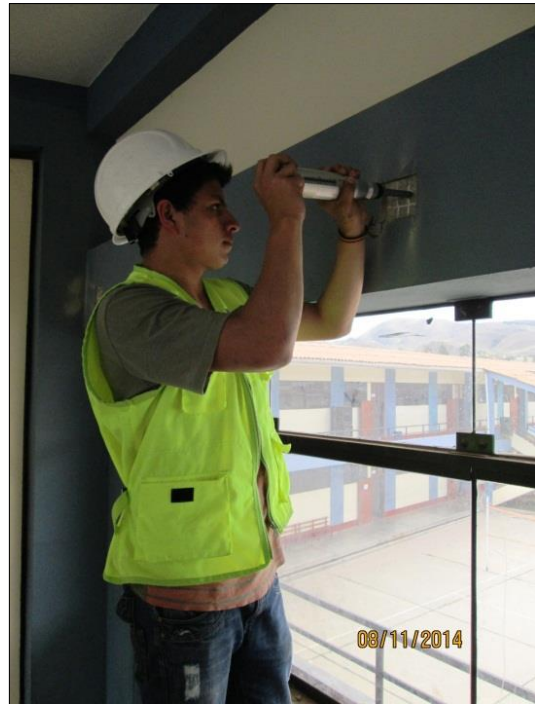
Ensayo de esclerometría en vigas
