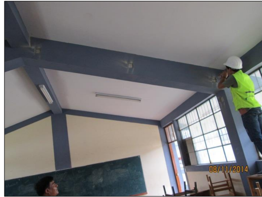
Tres puntos para realizar el ensayo de esclerometría en vigas
