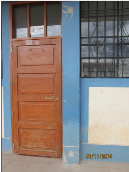
Columna habilitada para ensayo
