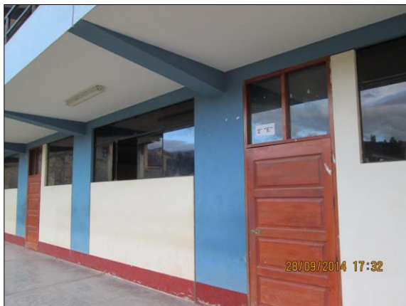
Vigas en voladizo
