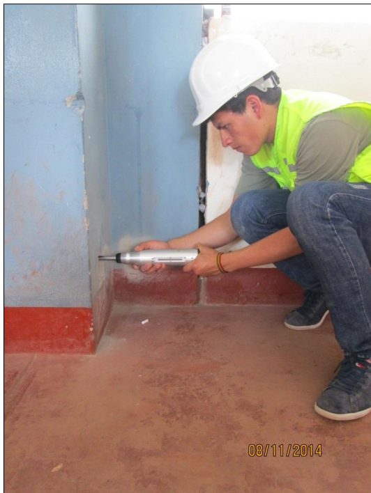
Ensayo de esclerometría en parte inferior de columna
