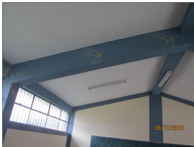
Viga habilitada para el ensayo
