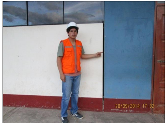
Junta de construcción pórtico - tabiquería
