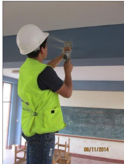
Sacando el tarrajeo a vigas
