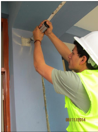
Ensayo de esclerometría en columnas
