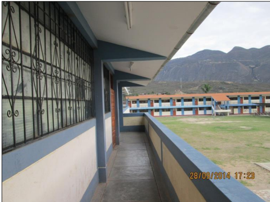
Vigas en voladizo
