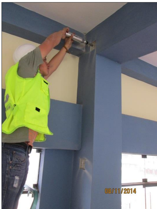
Ensayo de esclerometría en columnas
