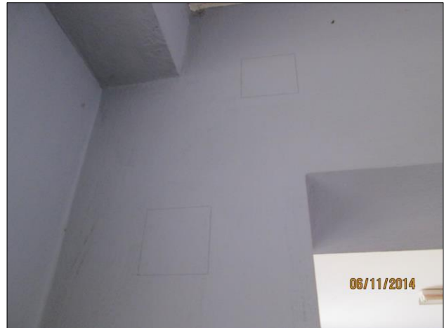
Muestras en vigas y columnas
