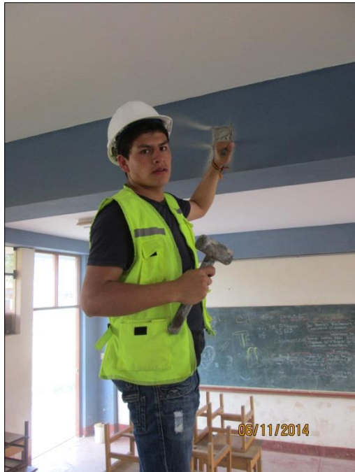
Sacando el tarrajeo a vigas
