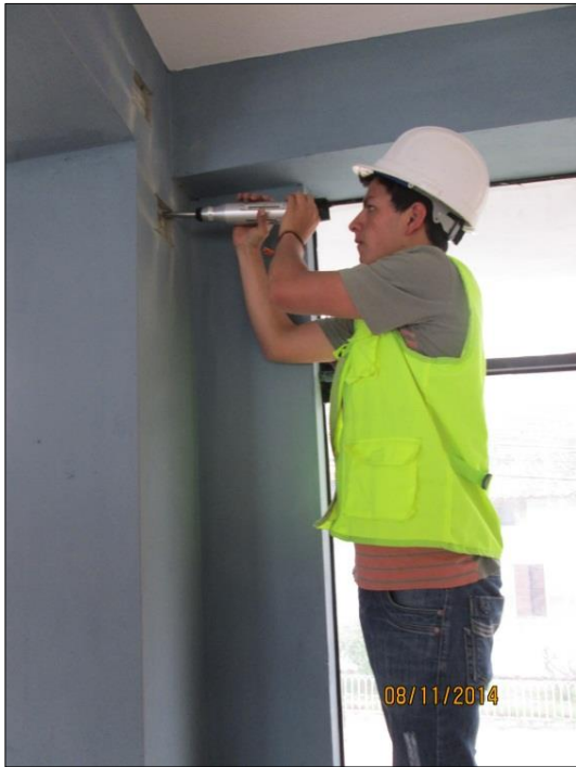
Ensayo de esclerometría en columnas
