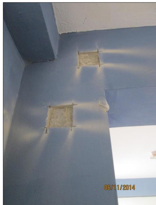
Muestras después del corte con cizalla
