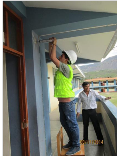
Ensayo de esclerometría en parte superior de columna
