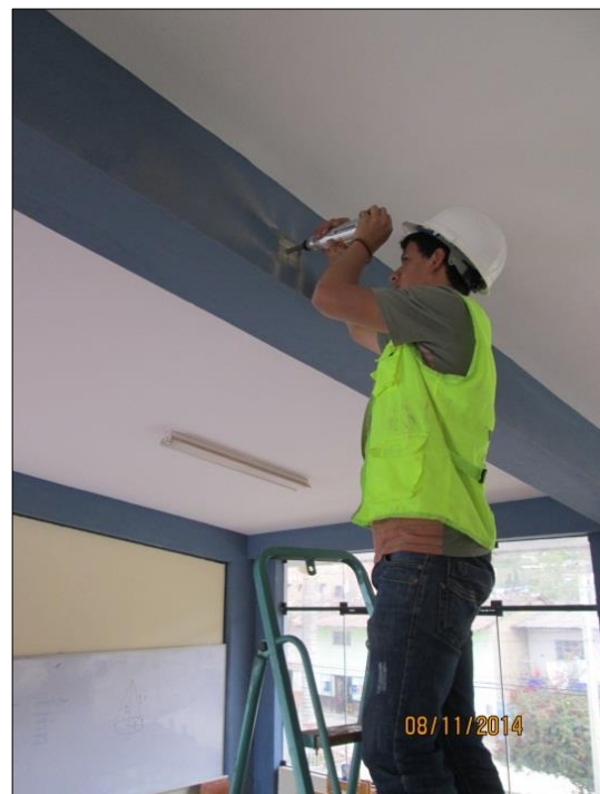
Ensayo de esclerometría en vigas
