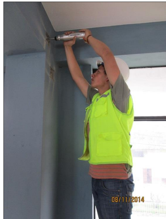
Ensayo de esclerometría en parte superior de columna
