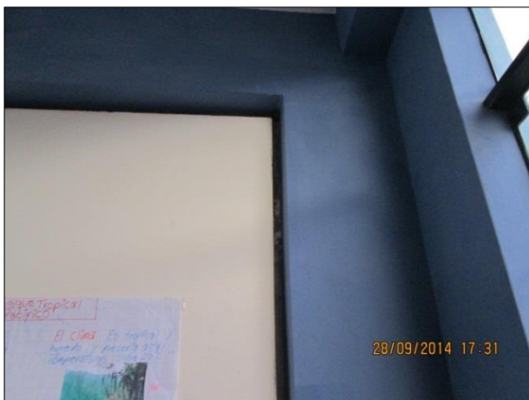
Junta de construcción entre pórtico y vanos
