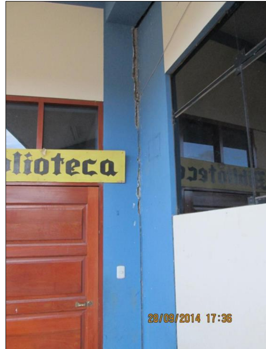
Junta sísmica pabellón "A" - "B"
