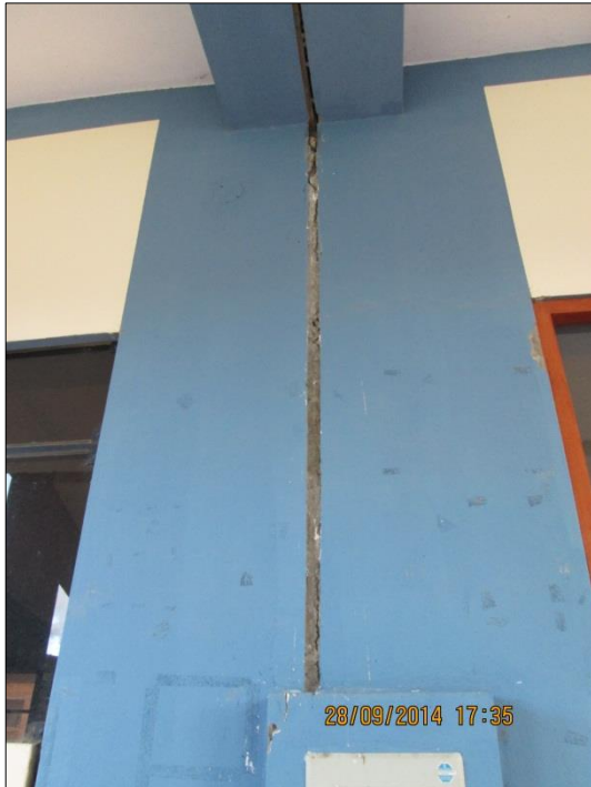
Junta sísmica entre bloques del pabellón "A"
