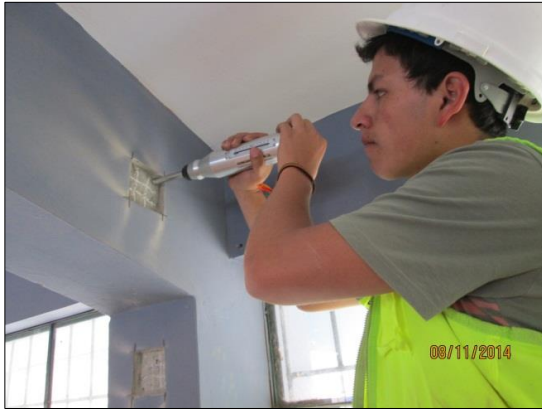
Ensayo de esclerometría en vigas
