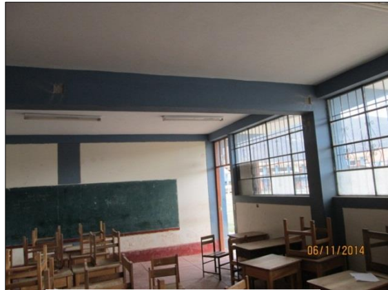
Viga habilitada para ensayo
