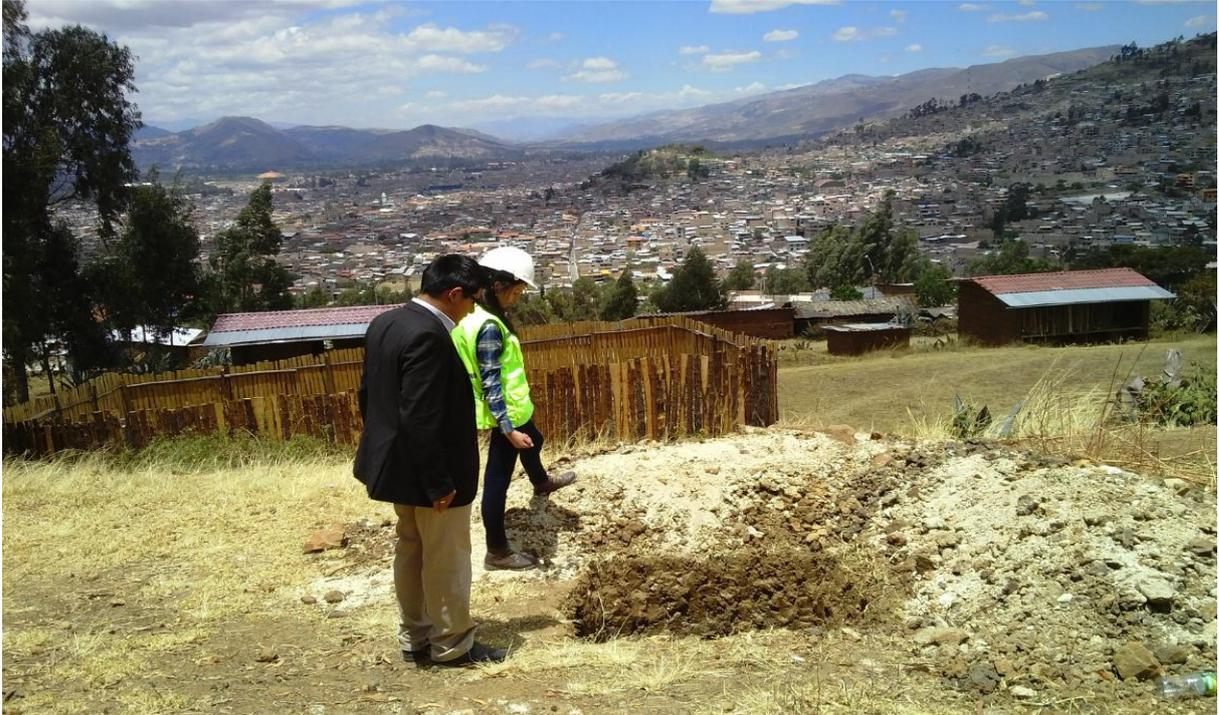
**FOTO N ° 3:** Inspección visual de la calicata N° 03 con el asesor de la tesis.
