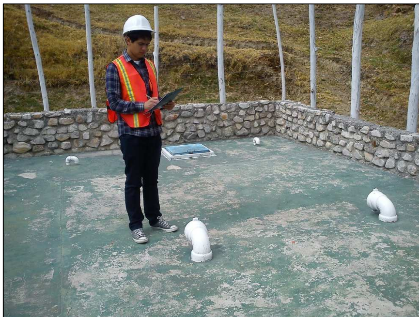
Inspección de la Infraestructura
