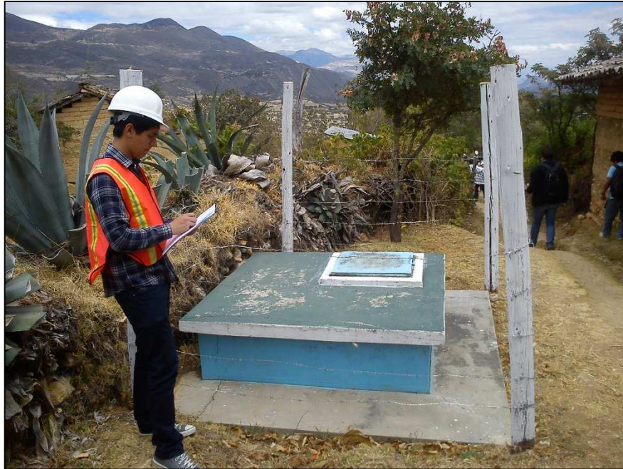
Inspección a cámara rompe presión
