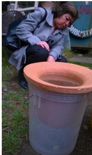
Foto 26. Prueba de filtración
