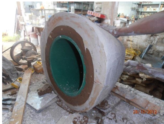
Foto 14. Colocación de yeso en patrón
