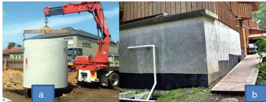
Gráfico 7: Transporte de cisterna de concreto: (a) 5 m 3 y (b) 75,6 m 3
