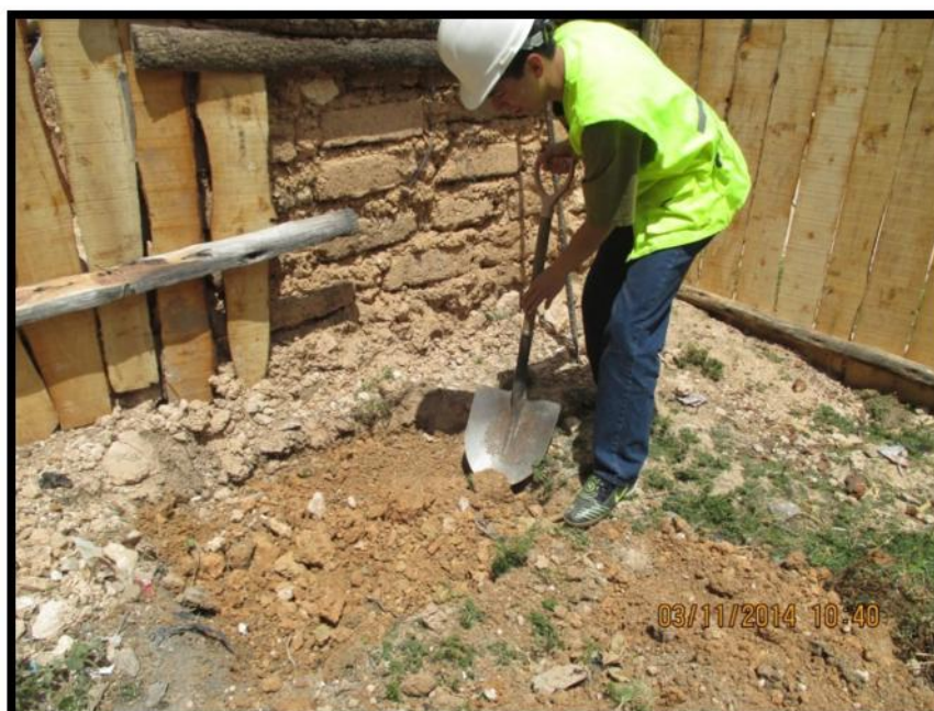
Excavación de Calicata N° 01.
