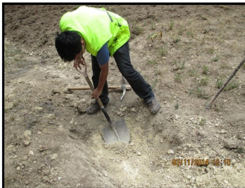
Excavación de Calicata N° 02.
