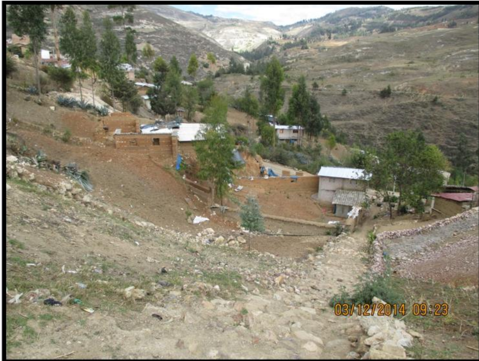
Zona de deslizamiento existente en Urubamba - 2
