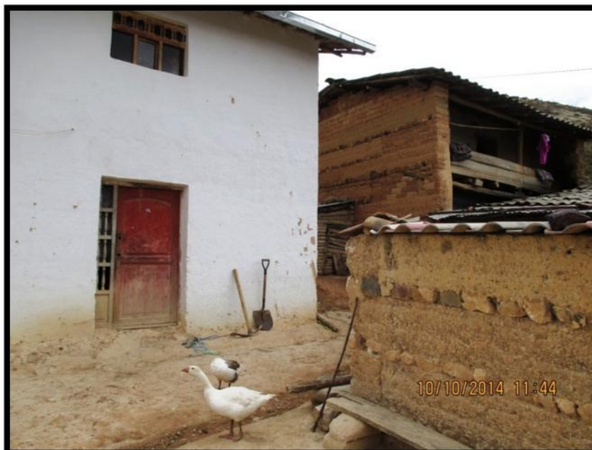
Material de Construcción predominante de la zona de estudio.
