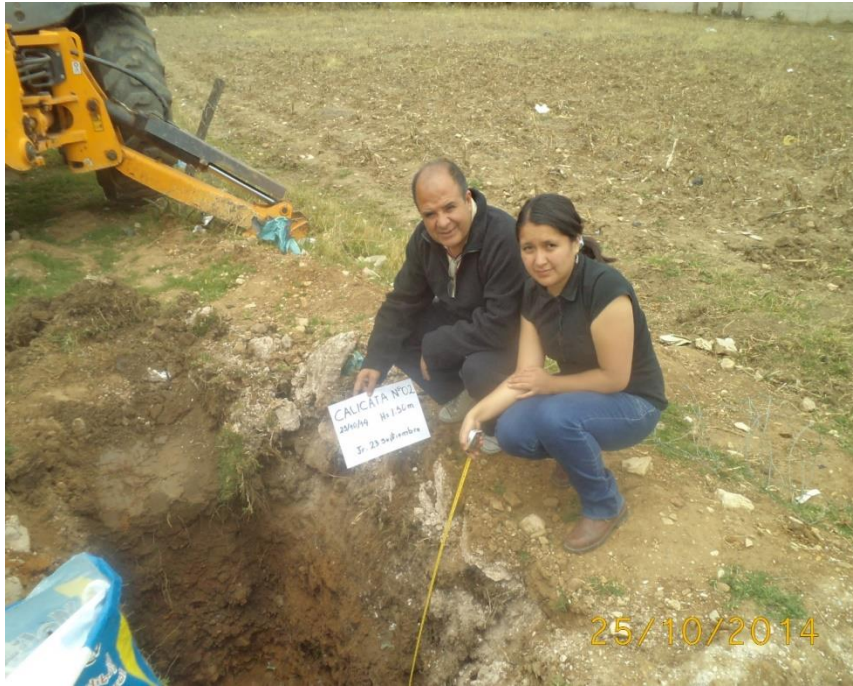
FOTO 05: Identificando la segunda calicata junto a mi asesor y determinando su profundidad
