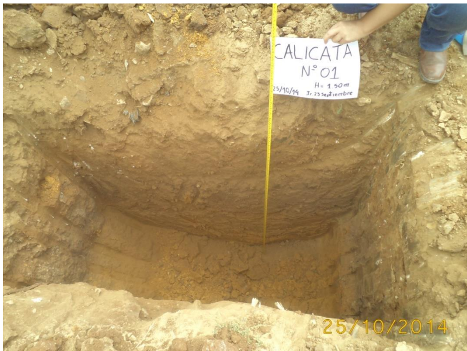
FOTO 02: Identificando la primera calicata y determinando su profundidad
