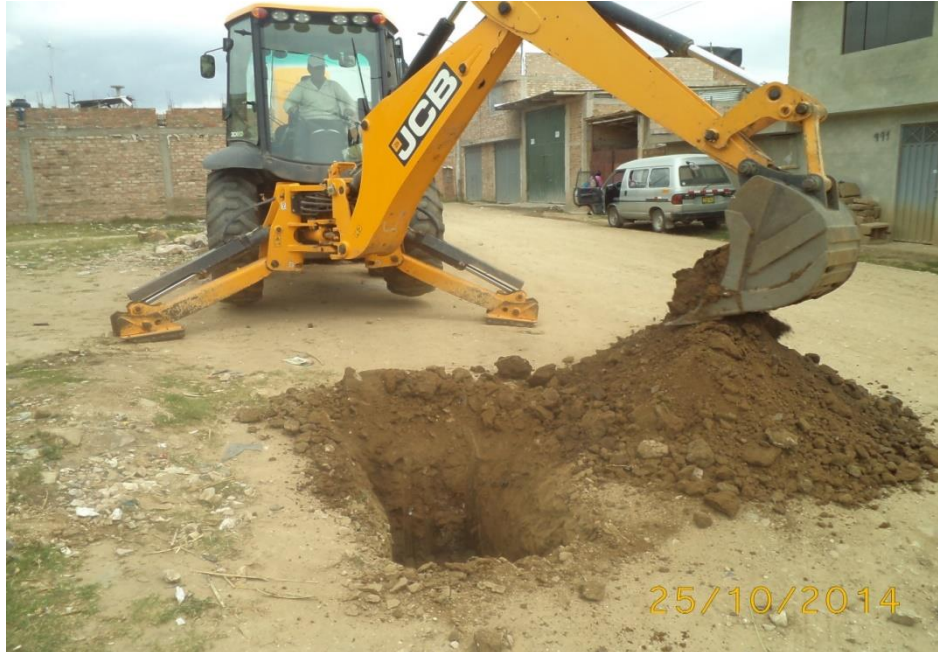
FOTO 01: Retroexcavadora realizando la calicata en el Jr. 23 de Septiembre
