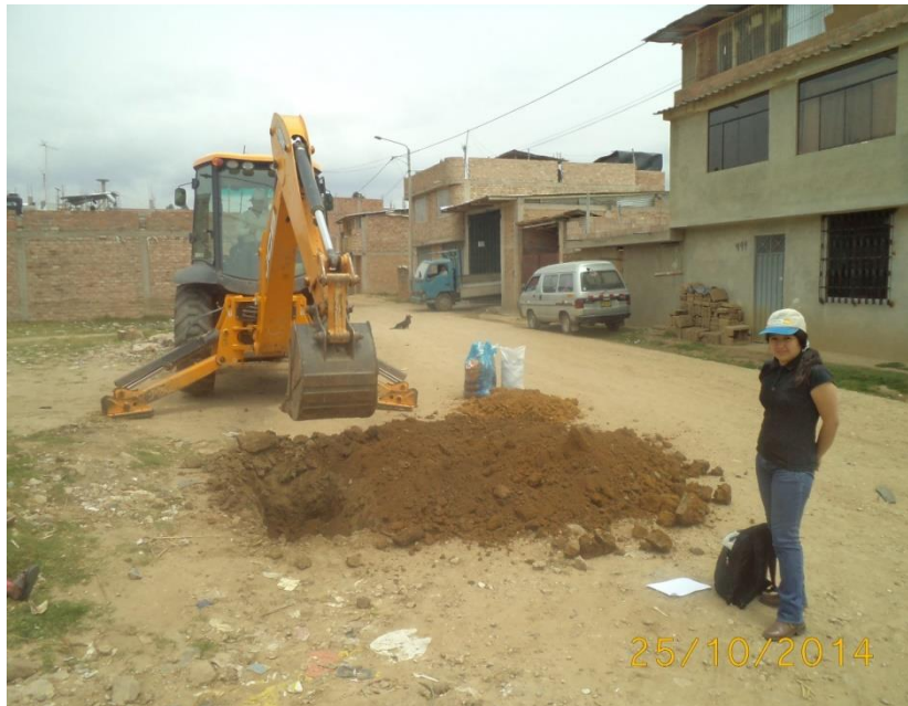
FOTO 03: Retroexcavadora tapando la calicata
