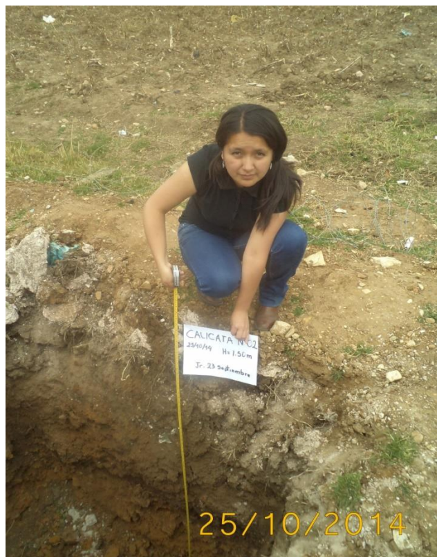
FOTO 04: Identificando la segunda calicata y determinando su profundidad
