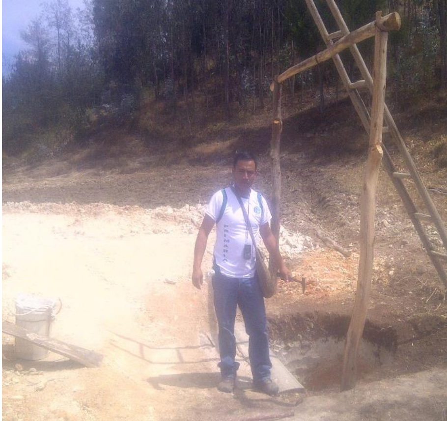
Imagen 19: Construcción del pozo. Elaboración: Propia
