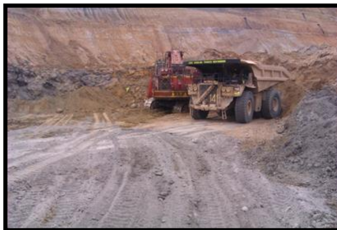
Fig. 5.12.- Estado final del piso de pala
