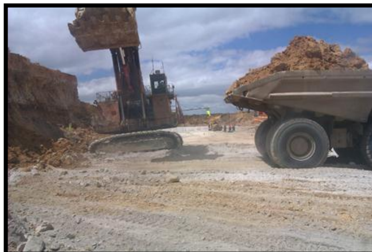
Fig. 5.17.- Carguío de camiones en piso estable
