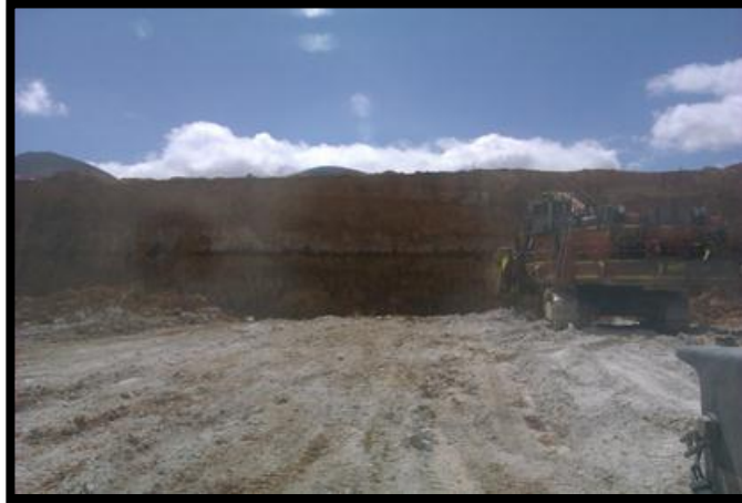
Fig. 5.16.- Lastrado del piso de carguío
