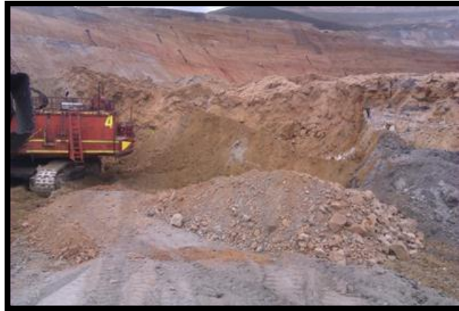
Fig. 5.11.- Lastrado del piso de pala
