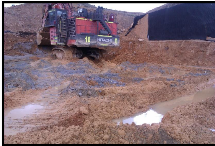
Fig. 2.16.- Estado de piso de carguío por efecto de lluvias
