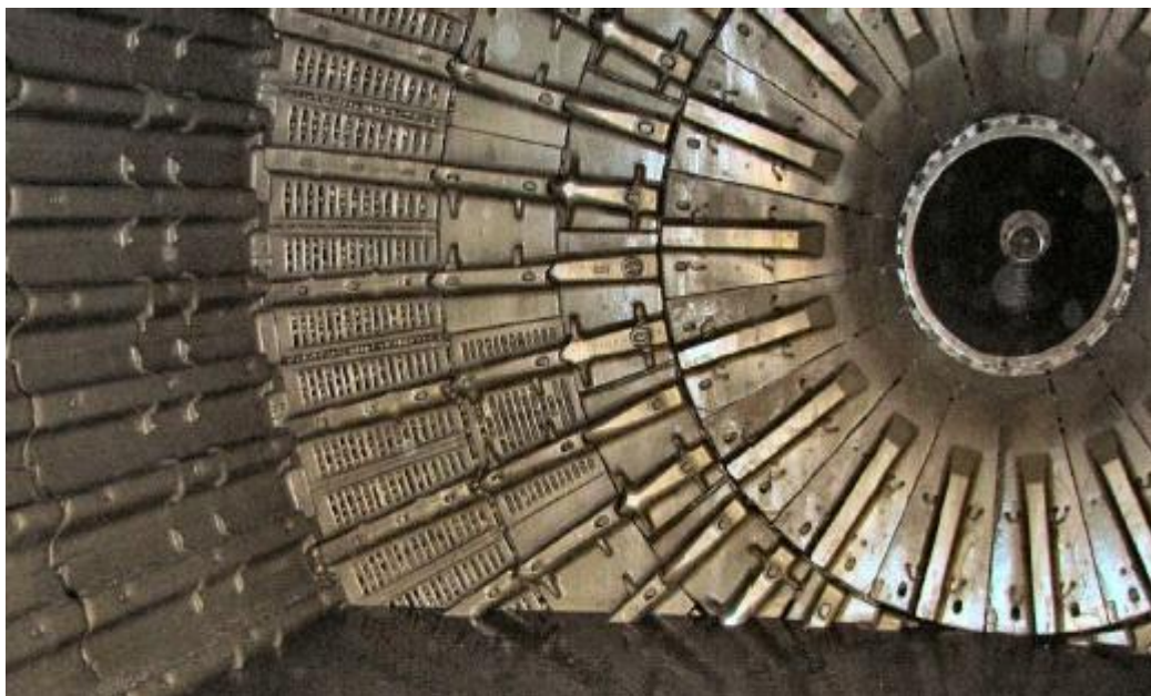
Figuras 18: Revestimientos al interior del Molino SAG.
