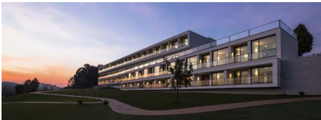
IMAGEN N° 25 Edificio Residencial para Adultos Mayores
