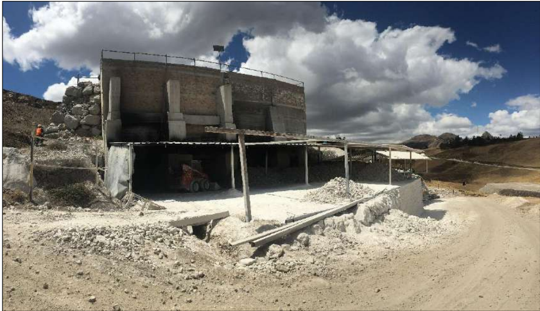
Figura n. ° 9. Vista panorámica de las bases de los hornos de la Planta de Cumbemayo.
