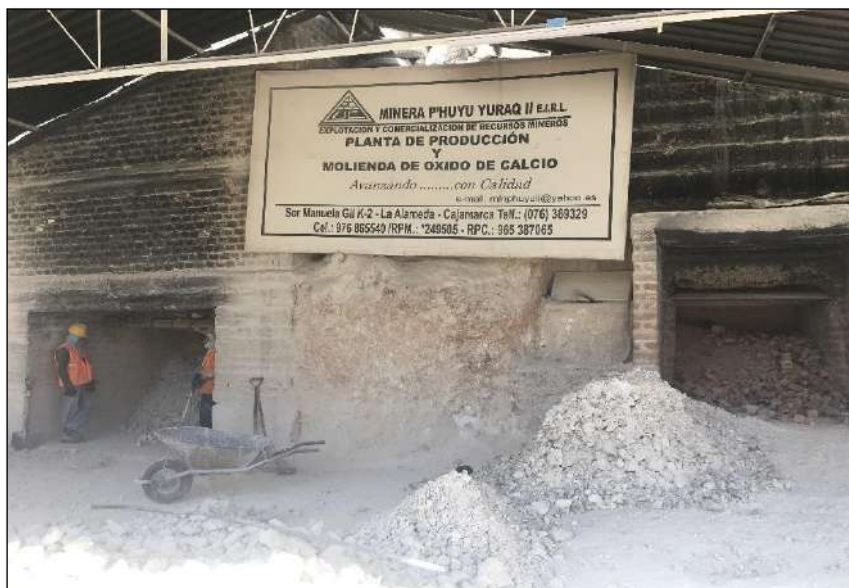
Figura n. ° 8. Bases de los Hornos de la Planta de Puylucana
